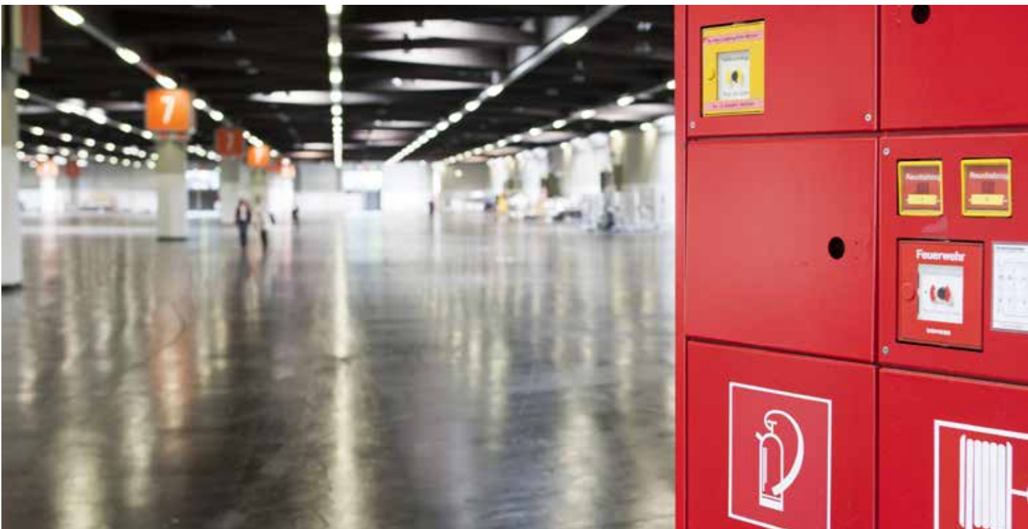
Jeder Betriebsmitarbeiter muss mit den Brandschutzeinrichtungen vertraut sein.
